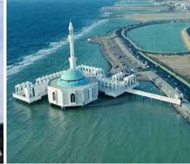
مسجدی در آب بحر احمر عربستان
